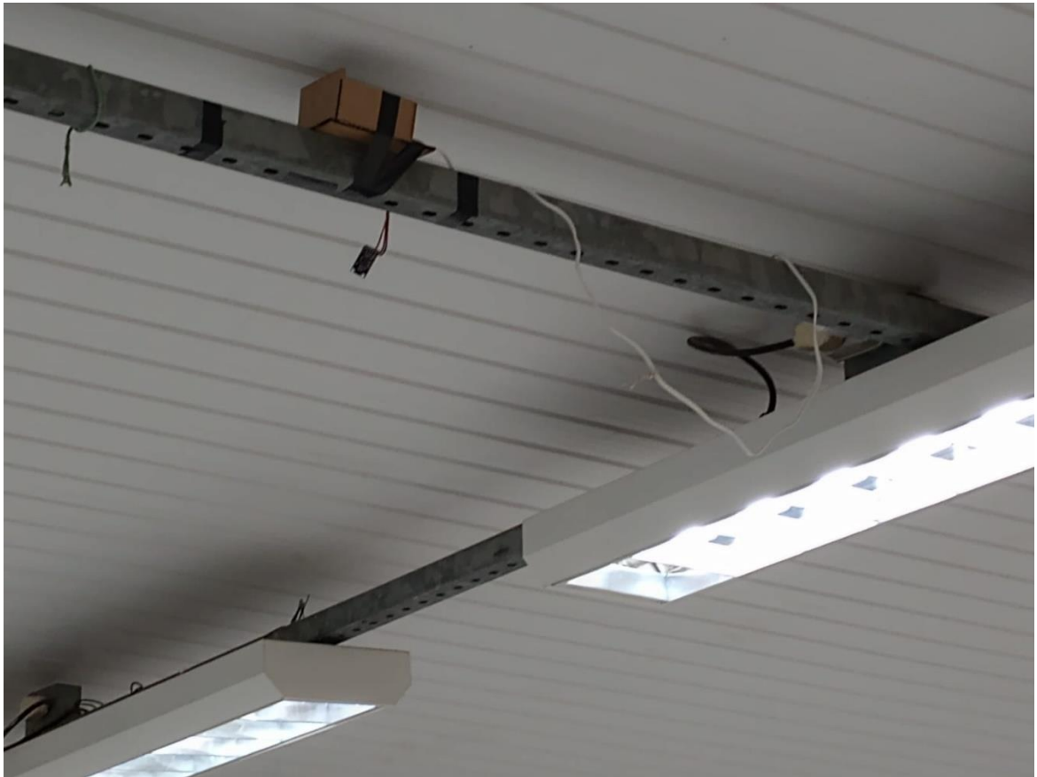
Figura 41 – Reinstalação na sala de aula
