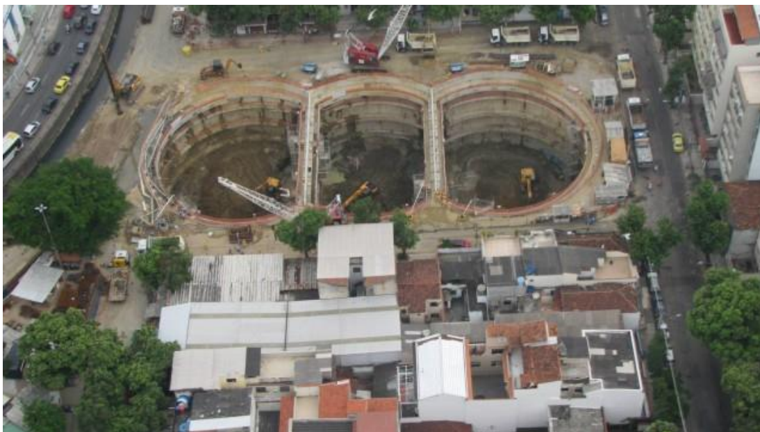
Figura 15 - Construção de Piscinão
